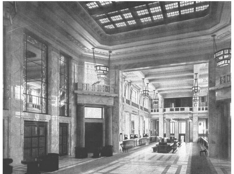
Kassensaal kurz nach Eröffnung der Bank im Jahr 1913 • The banking hall shortly after its opening in 1913
